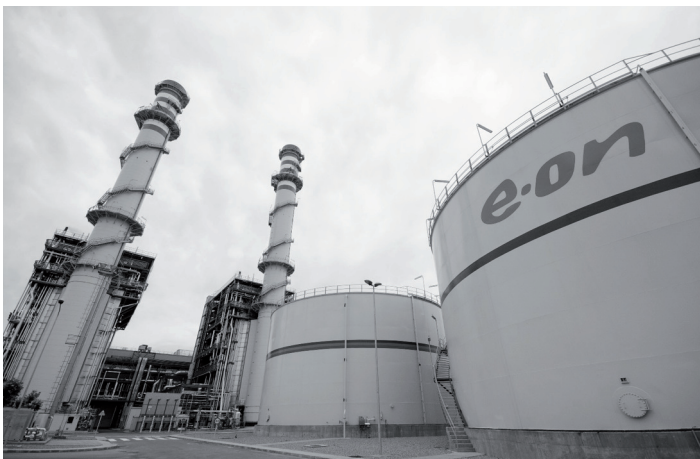
Mit einem Wirkungsgrad von 55 Prozent arbeitet das neue 818-Megawatt-Gas- und Dampfkraftwerk im spanischen Escatron besonders effizient
