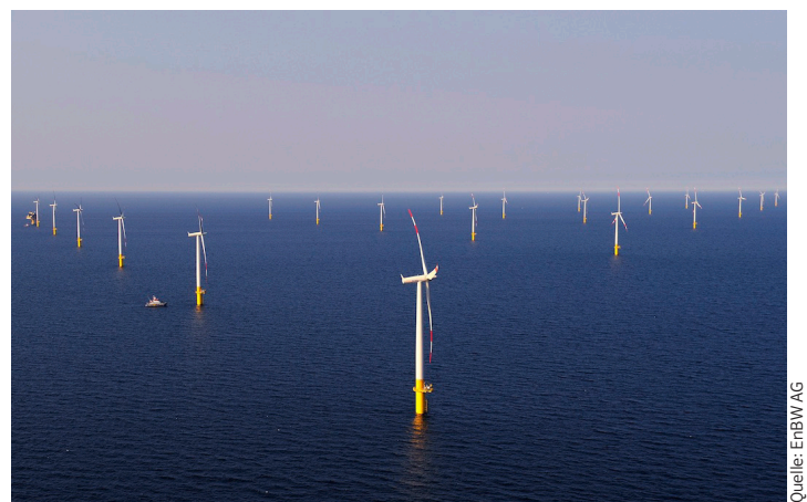
Anfang Mai hat mit Baltic 1 der erste kommerzielle Offshore-Windpark Deutschlands in der Ostsee seinen Betrieb aufgenommen. Die 21 baugleichen 2,3-Megawatt-Anlagen mit einer Gesamtleistung von 48,3 Megawatt werden von EnBW betrieben. Neben dem baden-württembergischen Energiekonzern sind 19 Stadtwerke an diesem Projekt beteiligt.
