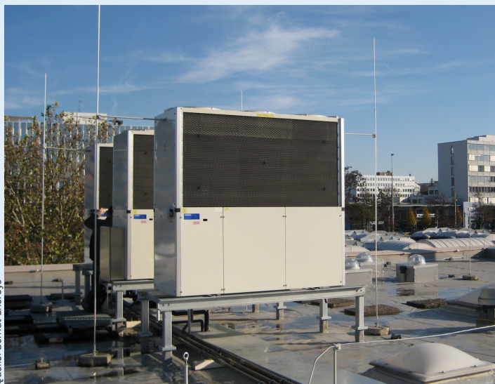
Drei Gaswärmepumpen mit Heizleistungen von jeweils 80 und Kühlleistungen von jeweils 71 Kilowatt klimatisieren 1.900 Quadratmeter Büro- und Besprechungsräume des Busbetriebshofes in Wiesbaden
