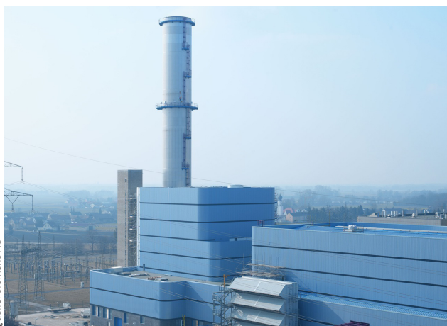
Quelle: Siemens AG Das Gas- und Dampfturbinen-(GuD)-Kraftwerk Irsching 4 arbeitet mit einem Wirkungsgrad von mehr als 60 Prozent. Herzstück der Anlage ist mit der SGT5-8000H die leistungsstärkste Gasturbine der Welt
