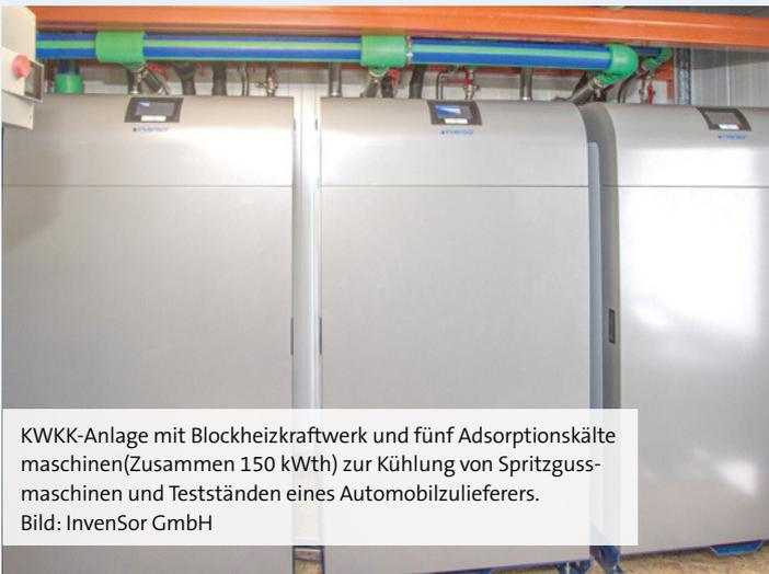
KWKK-Anlage mit Blockheizkraftwerk und fünf Adsorptionskältemaschinen (Zusammen 150 kW<sub>th</sub>) zur Kühlung von Spritzgussmaschinen und Testständen eines Automobilzulieferers.
