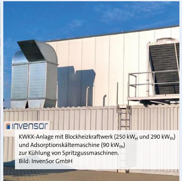
KWKK-Anlage mit Blockheizkraftwerk (250 kW<sub>el</sub> und 290 kW<sub>th</sub>) und Adsorptionskältemaschine (90 kW<sub>th</sub>) zur Kühlung von Spritzgussmaschinen.
