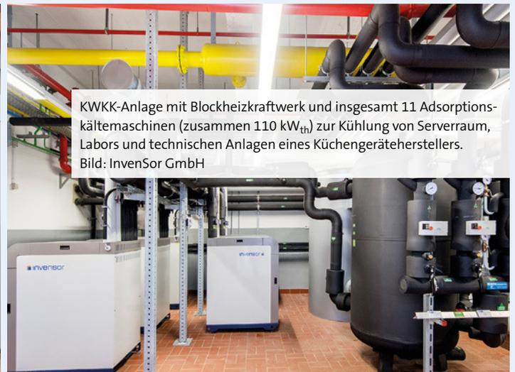
KWKK-Anlage mit Blockheizkraftwerk und insgesamt 11 Adsorptionskältemaschinen (zusammen 110 kW<sub>th</sub>) zur Kühlung von Serverraum, Labors und technischen Anlagen eines Küchengeräteherstellers.
