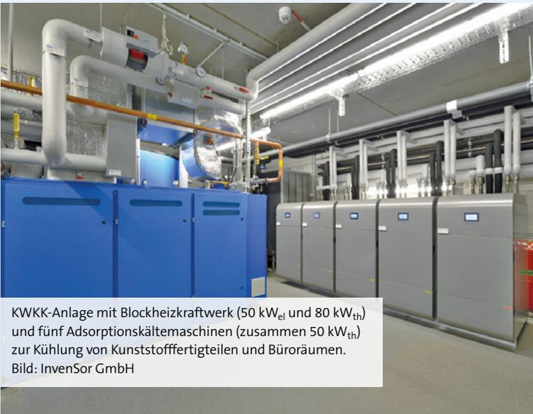
KWKK-Anlage mit Blockheizkraftwerk (50 kW<sub>el</sub> und 80 kW<sub>th</sub>) und fünf Adsorptionskältemaschinen (zusammen 50 kW<sub>th</sub>) zur Kühlung von Kunststofffertigteilen und Büroräumen.
