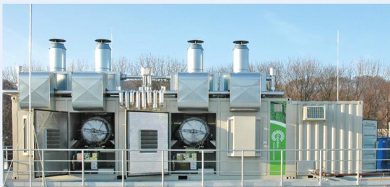
KWKK-Anlage mit vier Mikrogasturbinen (zusammen 800 kW<sub>el</sub> und 1400 kW<sub>th</sub>) und zwei verschiedenen Absorptionskältemaschinen (NH<sub>3</sub> für Tiefkühlung – 280 kW<sub>th</sub>, LiBr für Klimatisierung – 370 kW<sub>th</sub>) an einem Lebensmittelgroßmarkt.
