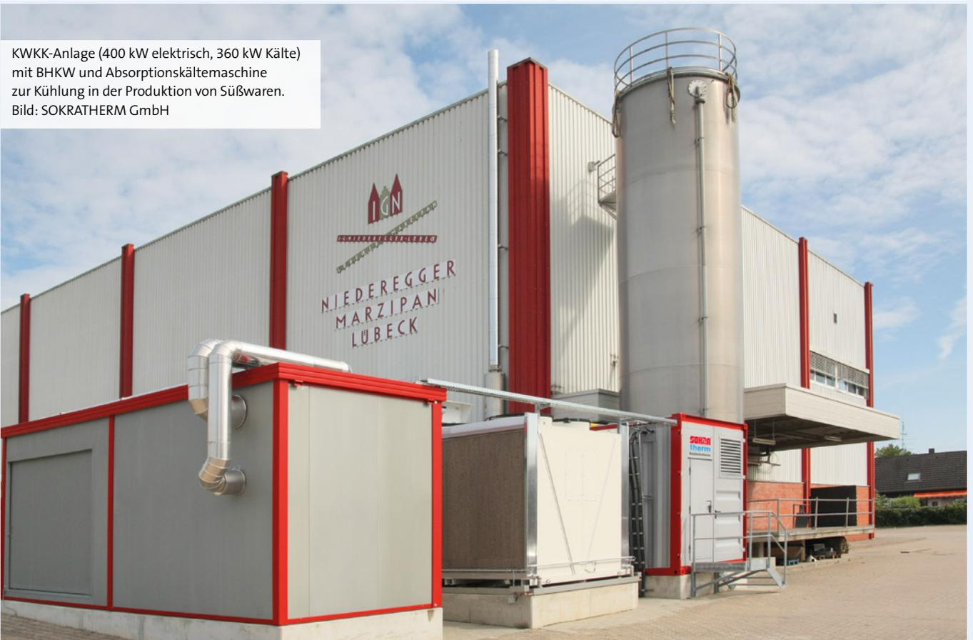
KWKK-Anlage (400 kW elektrisch, 360 kW Kälte) mit BHKW und Absorptionskältemaschine zur Kühlung in der Produktion von Süßwaren.
