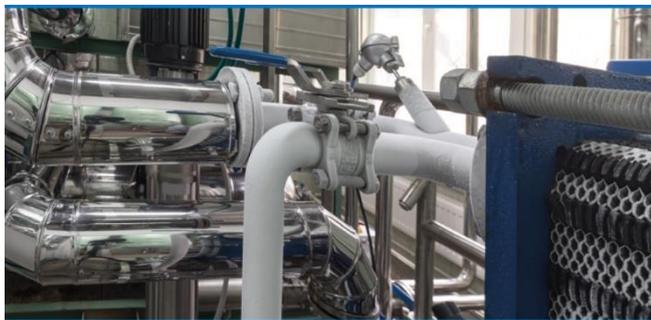
**Abbildung 1: Kälte-Leitungen an einem Wärmeübertrager in einer Technikzentrale (Bild aus ASUE-Broschüre „KWKK“)**
