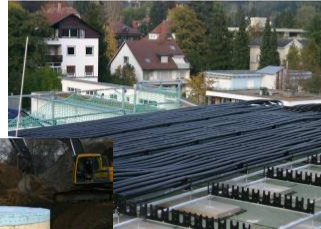
Flachdach- absorber (im Bau)
