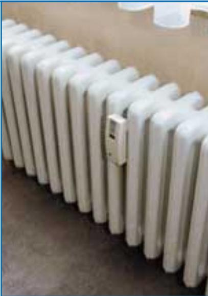
Nach § 5 HeizkostenV sind zur Erfassung des anteiligen Wärmeverbrauchs **Wärmezähler** oder **Heizkostenverteiler**, zur Erfassung des anteiligen Warmwasserverbrauchs Warmwasserzähler zu verwenden.
